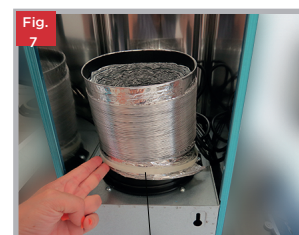
Presilha para fixar melhor duto e conexão
